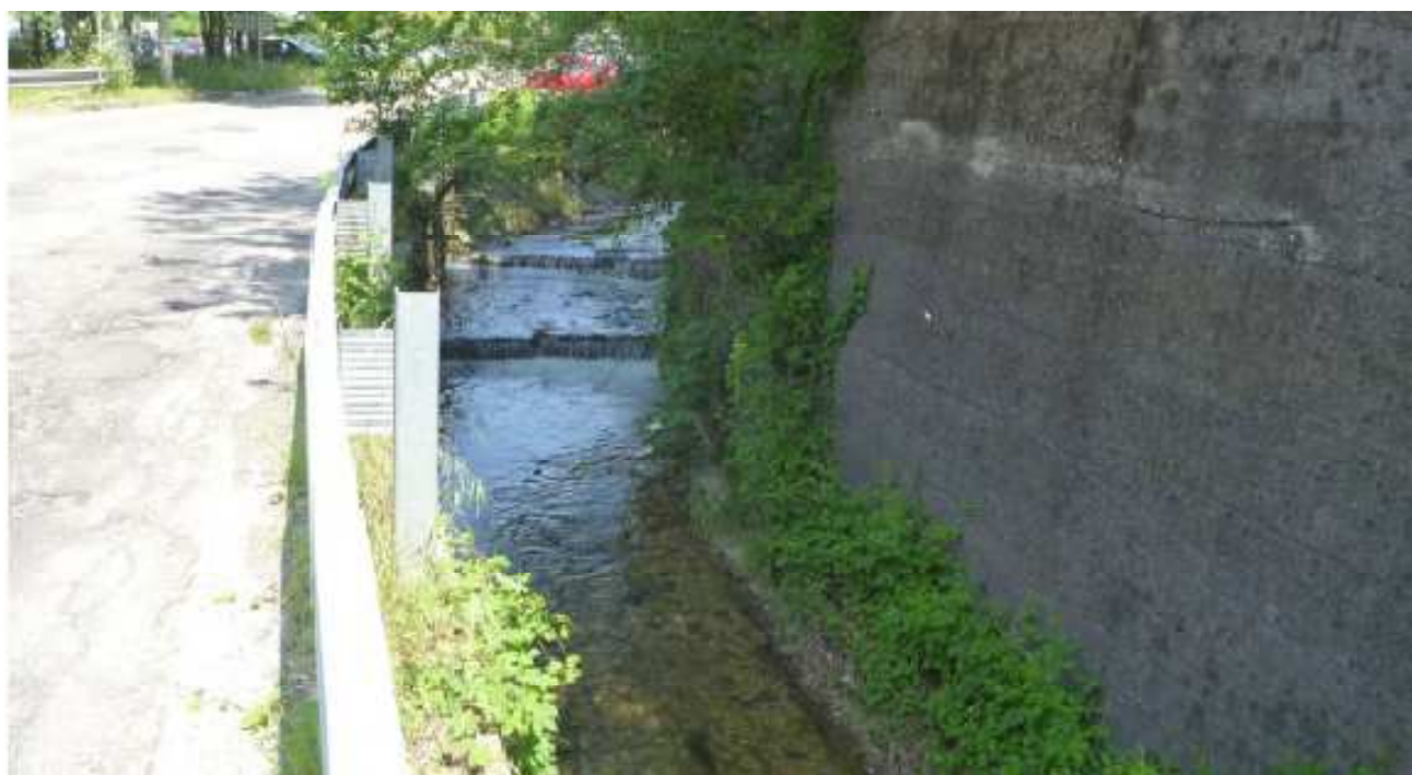
Foto 2 - Fiume Olona, tratto a monte della confluenza con Ramo Rasa.
